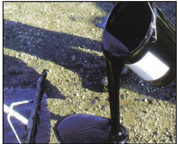
Step 15-B – POUR MATERIAL ONTO PREPARED ROOF SURFACE
